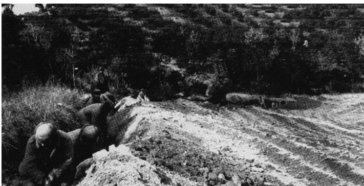
从1951年2月17日起,全线采取机动防御。图为中国人民志愿军某部在汉江北岸构筑防御工事。
