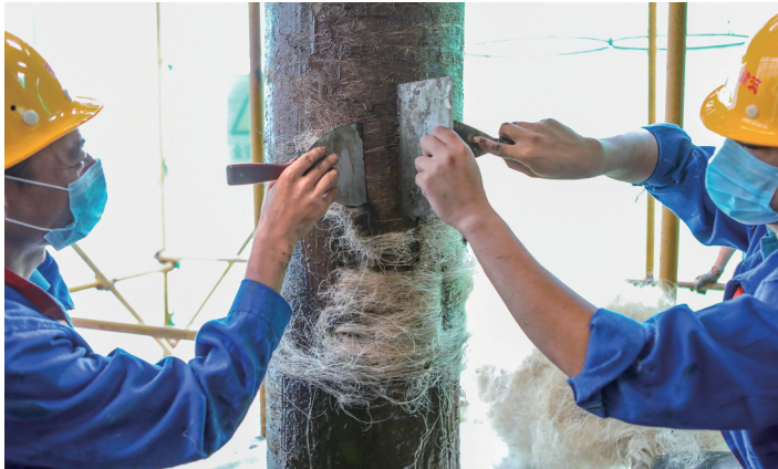
施工人员现场示范“轧压麻”工序，使用麻压子逐次将麻压实。
