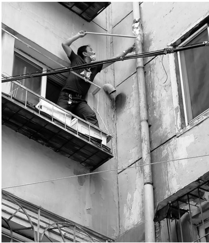
沈阳市皇姑区黄河街道扬子江社区工作人员王丽东正在帮居民白奶奶家断开的水管实施“手术”。皇姑区供图
