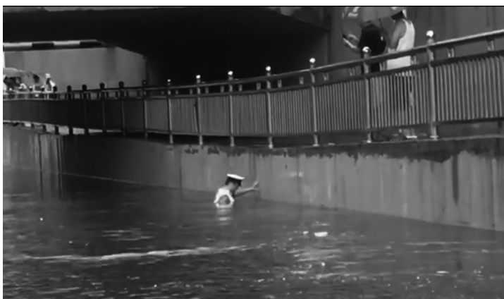
高峰在水中检查排水井。
