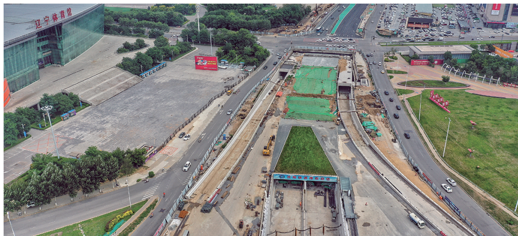
沈阳浑南大道快速路隧道工程建设主体结构提前一个月完工。
