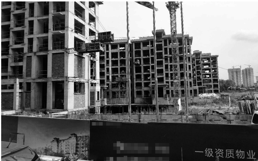
工地停工一年,看不到工人和任何工作的工程设备。
