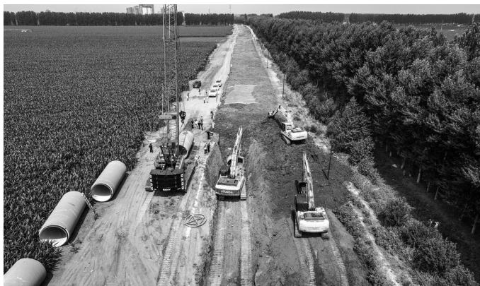
辽西北供水工程沈北段管线铺设已完成过半。 辽沈晚报首席记者 查金辉 摄
