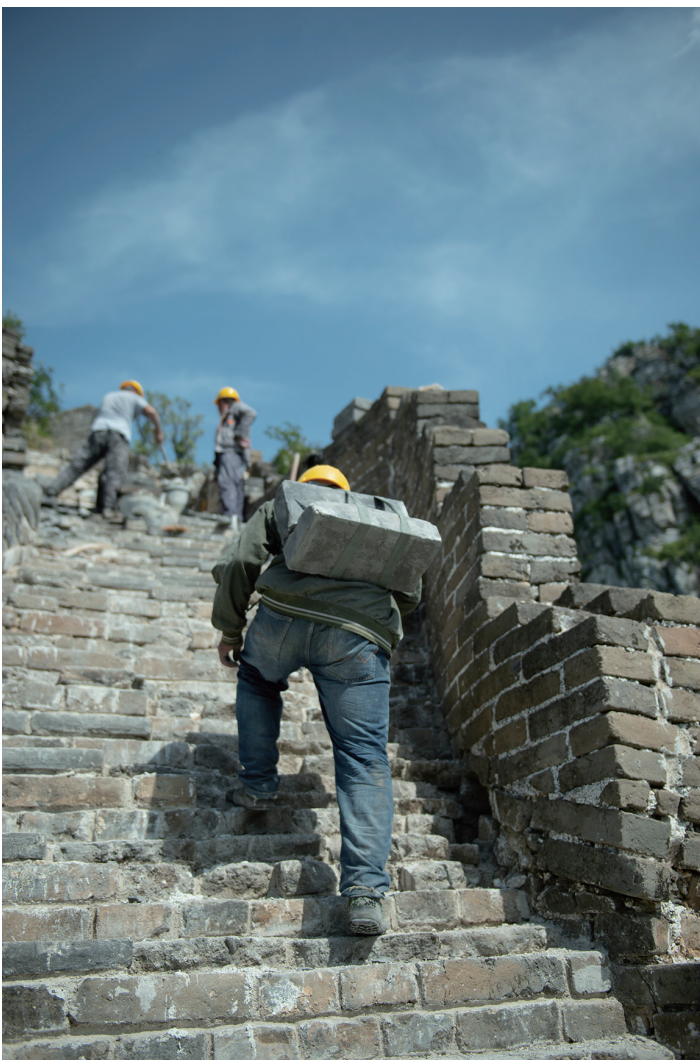
修缮工人背着砖前往工程作业面。
