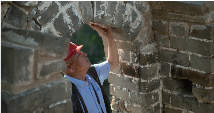
程永茂在检查修缮后的长城敌楼门洞。
