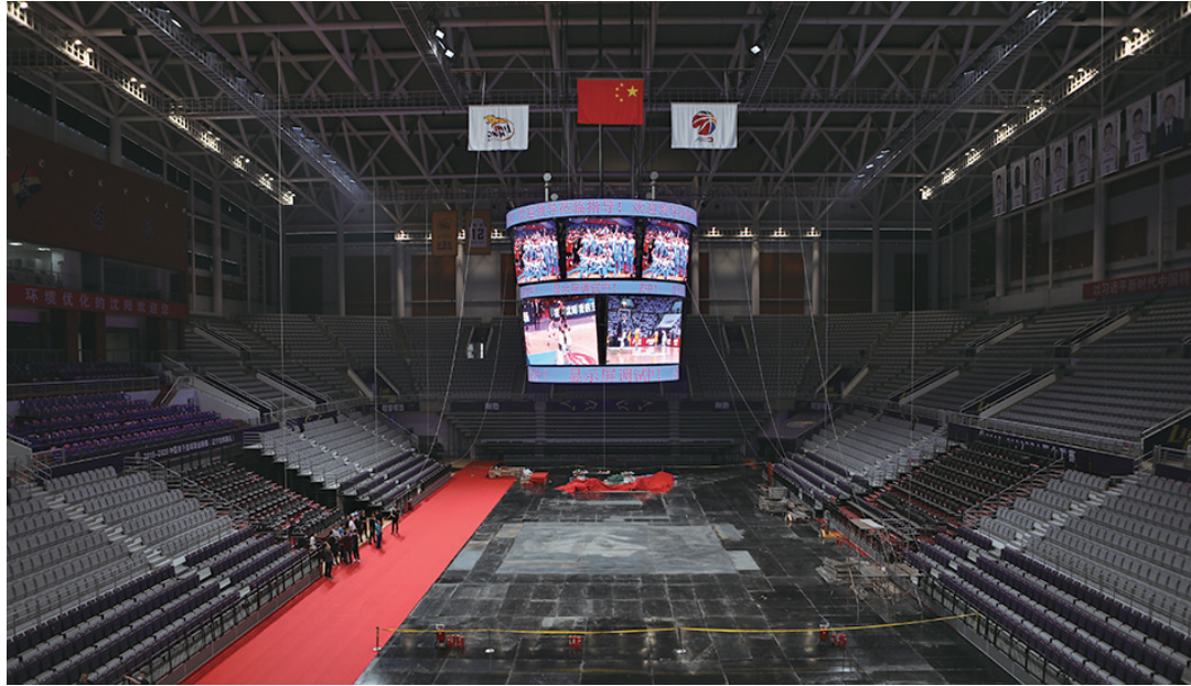
辽篮主场的斗屏安装,开始调试。
