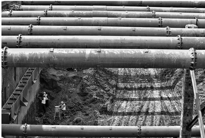
沈阳地铁二号线南延线科技园站施工现场。 辽沈晚报记者 查金辉 摄
