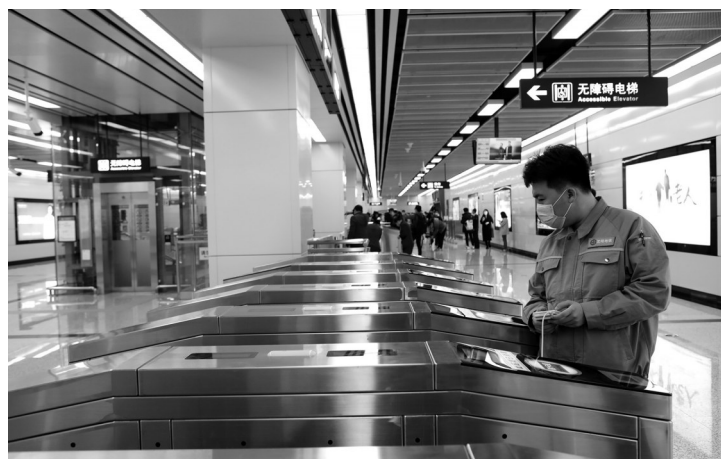
工作人员调试闸机。
