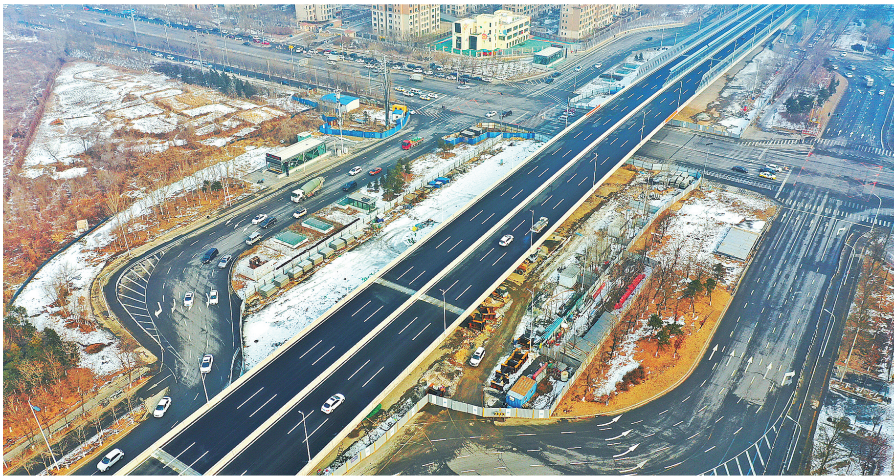
12月29日上午,沈阳浑南大道金阳大街节点桥顺利通车。
