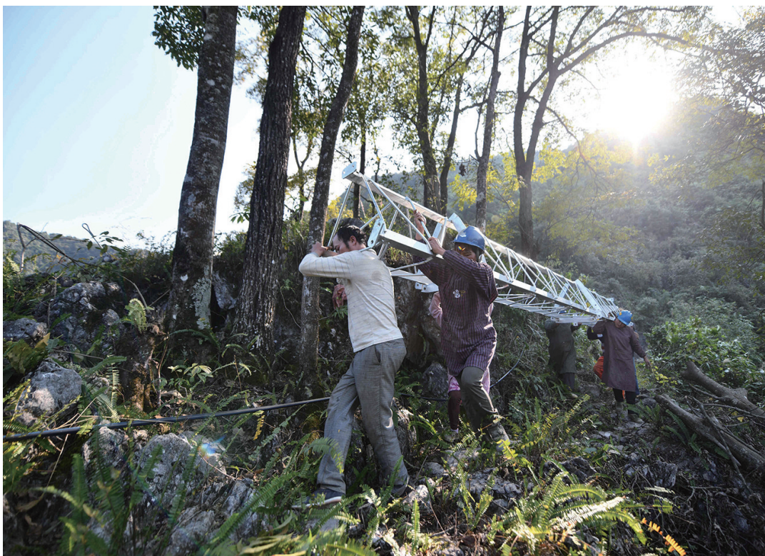
在广西大化瑶族自治县板升乡八好村,工人抬着电线塔上山,准备对线路进行升级改造。
