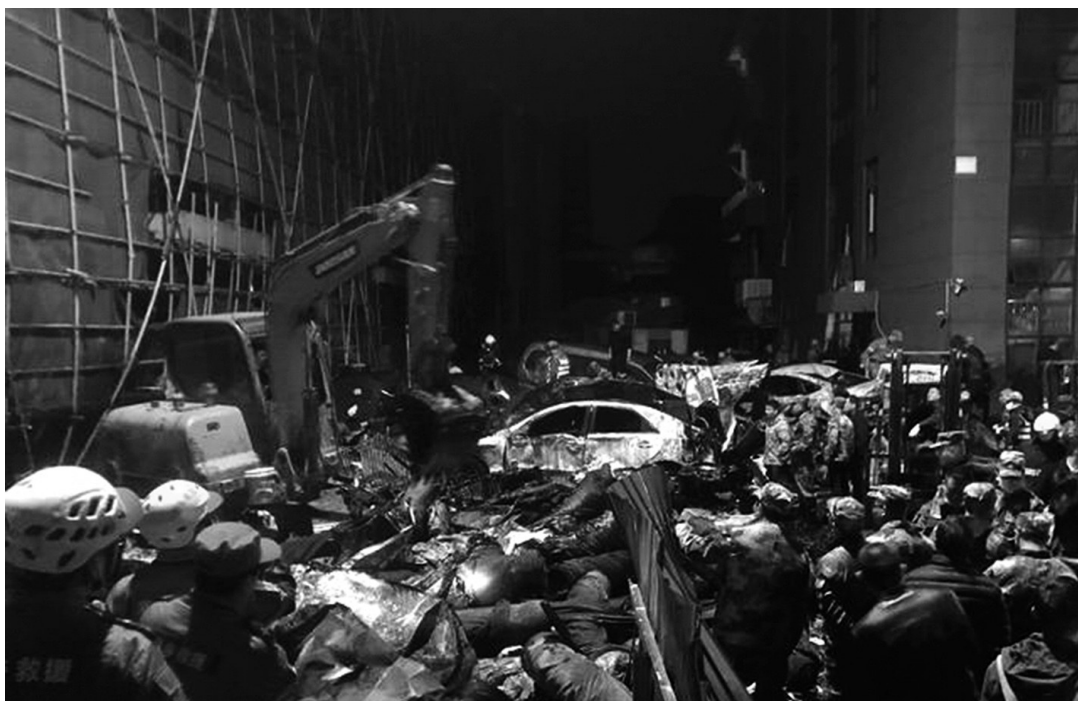
浙江海宁污水罐坍塌事故死亡人数已上升至9人。这是12月3日拍摄的事故现场。 新华社发
