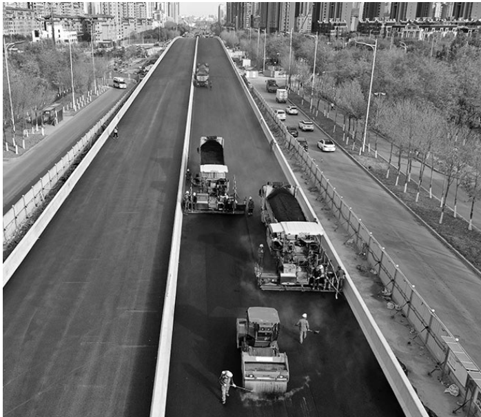
浑南大道快速路金阳大街跨线桥摊铺路面层沥青混凝土,其中添加了防冰融雪材料。
