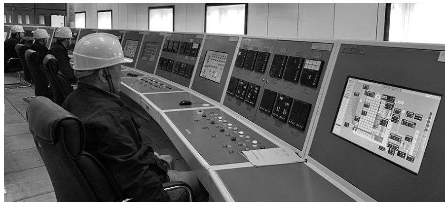
在锅炉控制室内现实出水温度超过80度。
