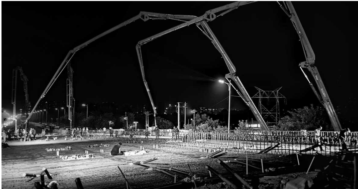
随着最后一片现浇混凝土箱梁浇筑完成,沈阳浑南大道快速路南京街节点桥桥梁工程合龙,开始进入桥面系统工程施工。
