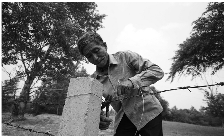
侯贵在修理林地周围破损的围栏。
