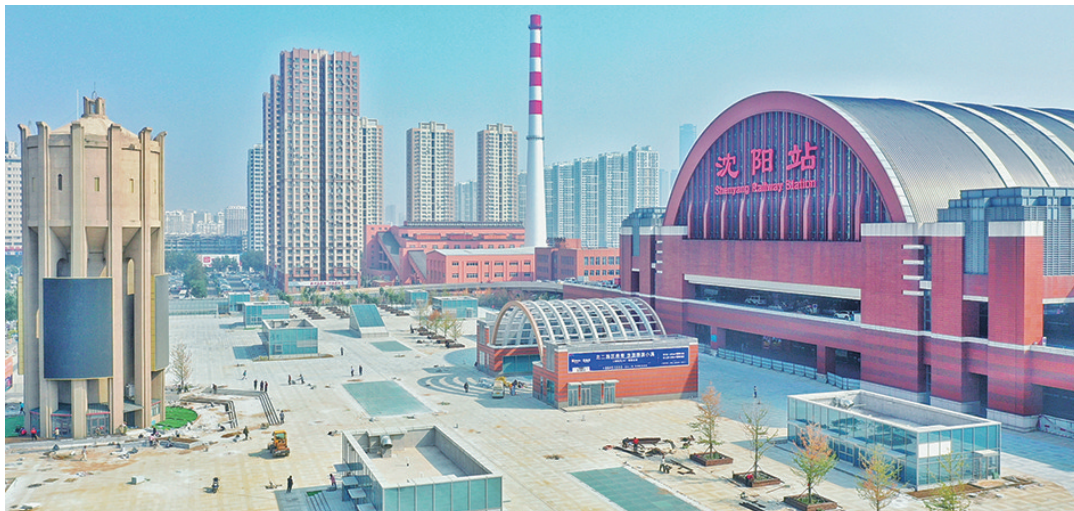
国庆节期间,沈阳站西广场正式投入使用。
