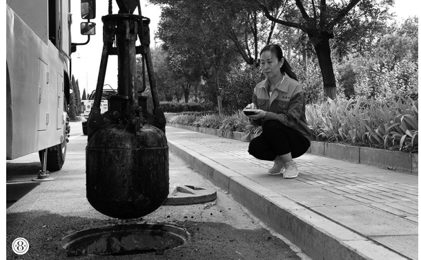
图⑦为1983年,湖北省黄石市城乡建设局市政工程管理处下水道班的工人进行清污工作;图⑧为2019年6月25日,山东省高唐县市政路桥工程有限责任公司员工金兴环用遥控器操纵清淤车,对城区污水管道检查井沉淀池进行清掏作业。
