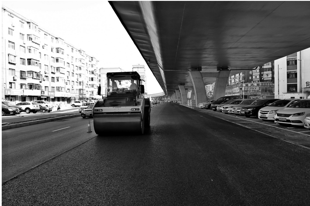
沈阳东一环快速路地面道路开始进行最后面层沥青混凝土摊铺施工。 辽沈晚报、聊沈客户端首席记者 查金辉 摄
