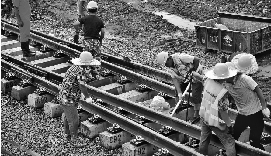
在桑林子车辆段施工现场,施工人员正在地面铺轨。 辽沈晚报、聊沈客户端首席记者 查金辉 摄
