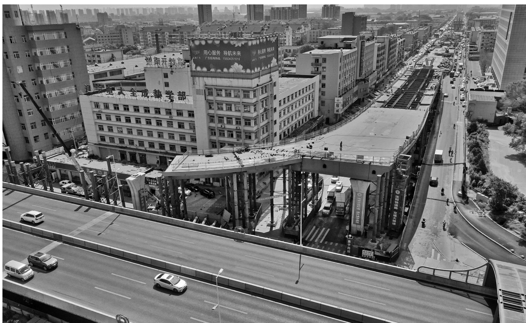
7月26日,东一环快速路与长青街快速路交会处的施工现场。
