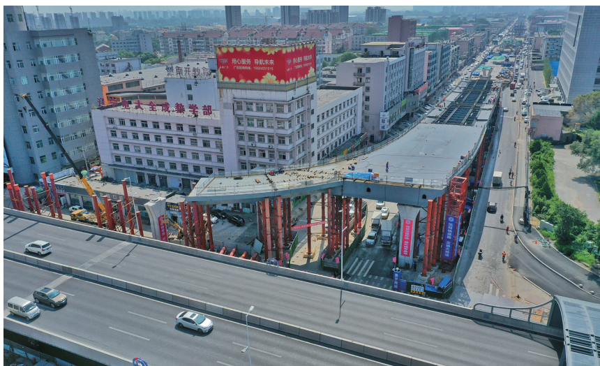
7月26日,在沈阳东一环快速路与长青街快速路交会处的施工现场,在一个个台墩柱的支撑下,高架桥的雏形已经呈现。 辽沈晚报、聊沈客户端首席记者 查金辉 摄
