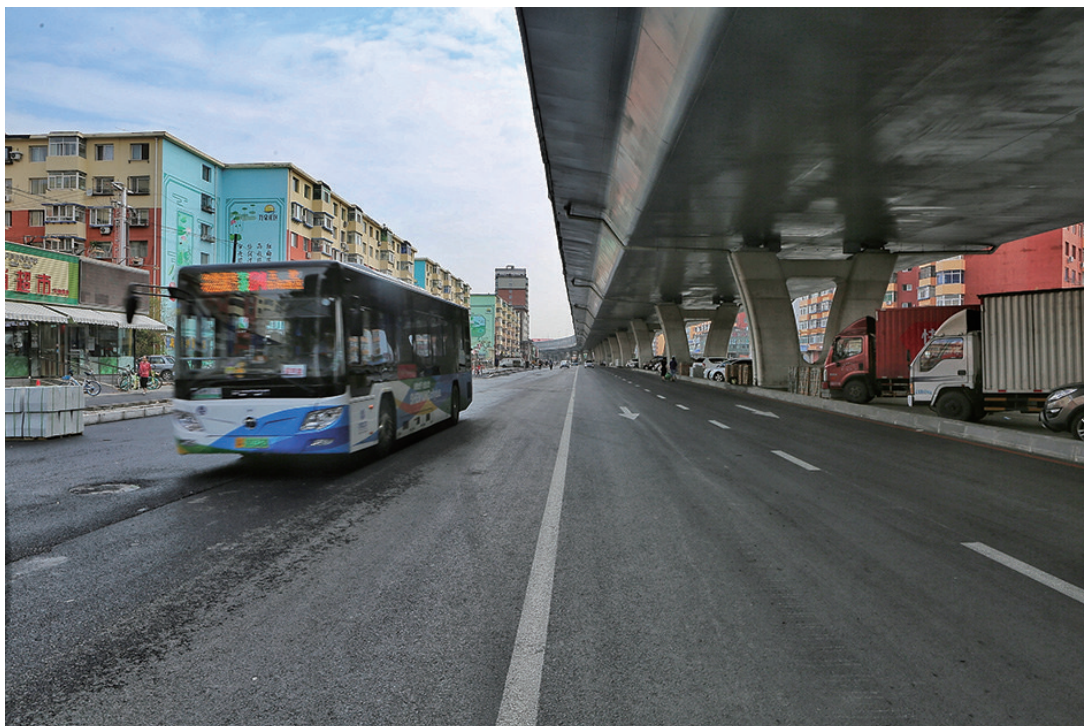
7月11日,东一环快速路临时恢复地面通行。
