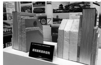
超低能耗墙体结构。
