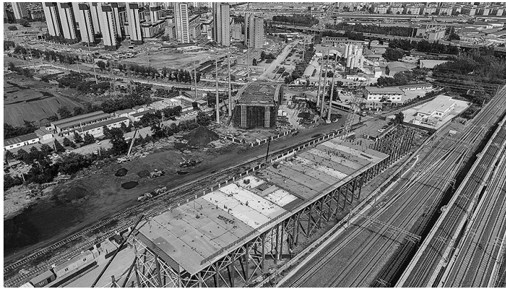
建设中的沈阳昆山西路与304国道连通的高架桥工程转体主桥钢箱梁开始吊装。 辽沈晚报、聊沈客户端首席记者 查金辉 摄
