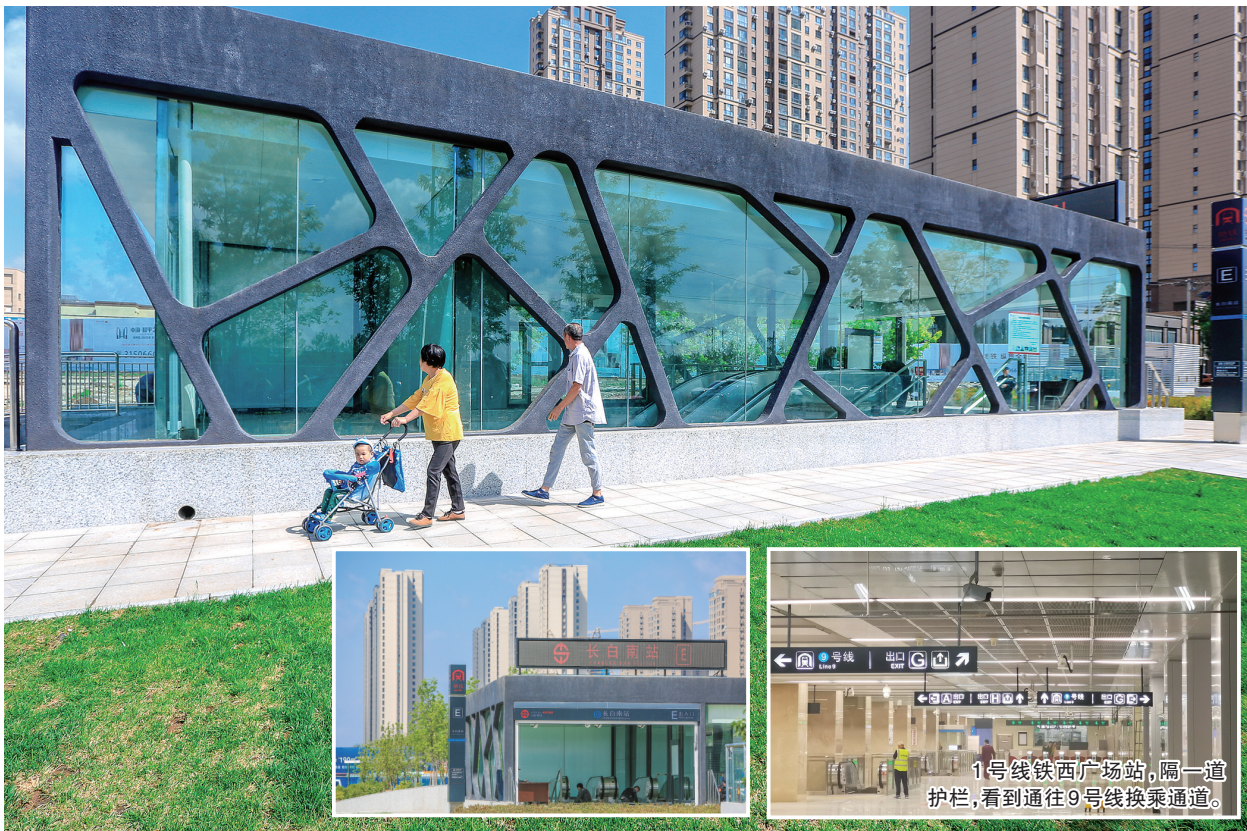
9号线车站出入口罩棚采用钢结构外露形式,表面形成“冰裂纹”的效果,既展现了沈阳作为老工业基地的文化底蕴,也体现了东北的气候特色。 辽沈晚报、聊沈客户端首席记者 查金辉 摄 08
