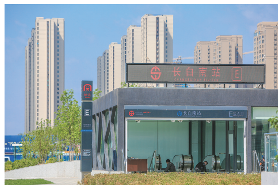
5月13日,在地铁9号线长白南站,E出入口已经撤掉围挡,工作人员正在调试扶梯。
