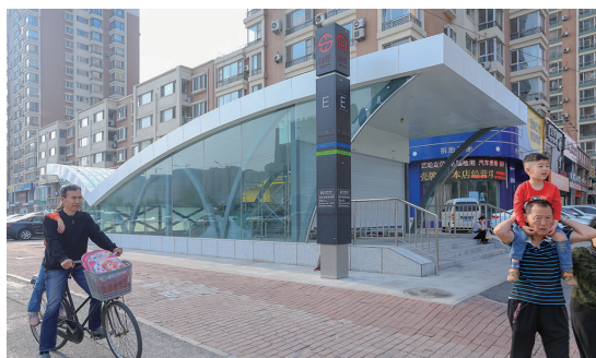
淮河街沈医二院站是地铁9号线和10号线的换乘站,出入口罩棚采用10号线的水波浪造型,同时搭配有弧度造型钢结构幕墙。
