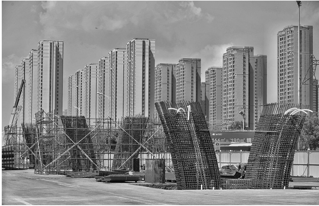
沈阳浑南大道快速路进入基础施工阶段。
