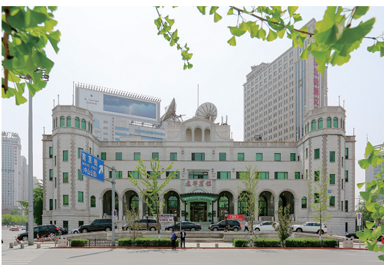
大和旅馆旧址
