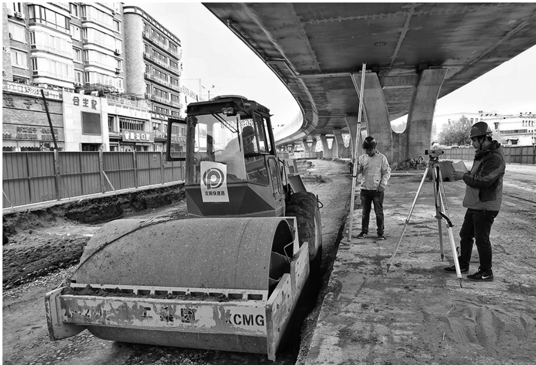
沈阳东一环快速路地面道路开始进行桥下空间利用、道路整修、人行过街设施建设等施工。
