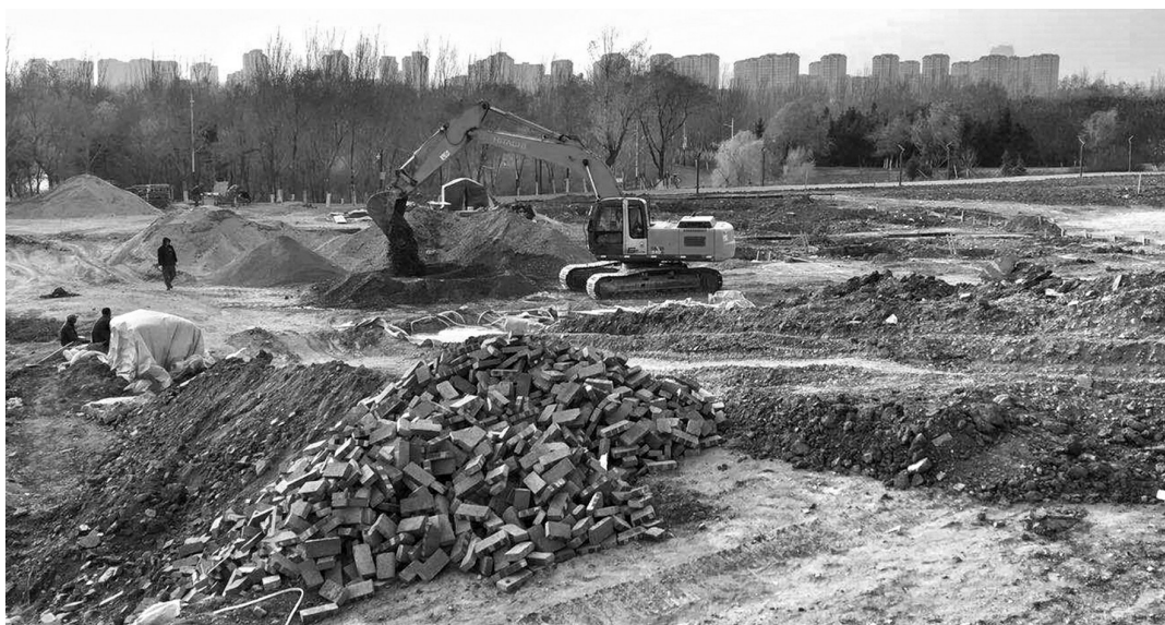
在沈阳浑河南岸长青湾公园,挖掘机正在加紧施工,进行绿化作业。 辽沈晚报、聊沈客户端首席记者 查金辉 摄
