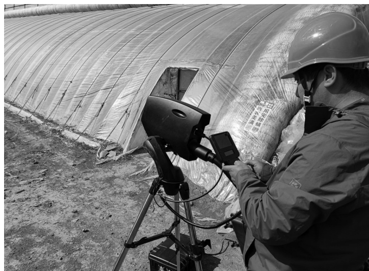
作业人员利用“激光炮”仅用几分钟就清除了导线上缠绕的塑料。
