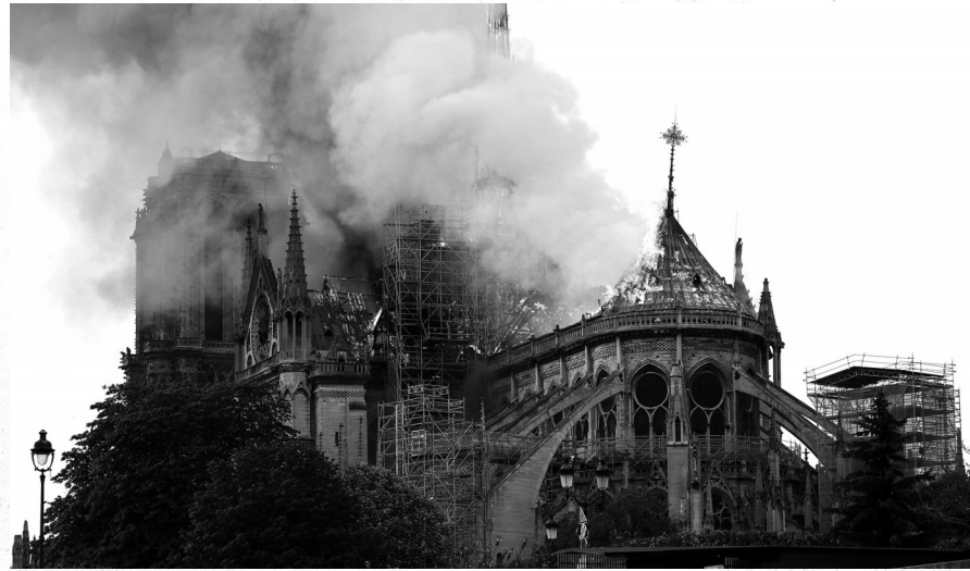
法国巴黎圣母院4月15日晚遭遇大火,整座建筑严重损毁。
