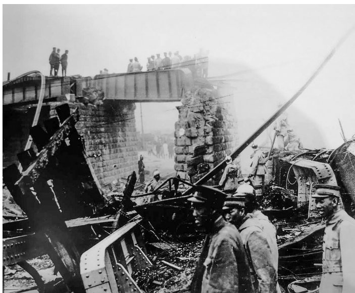
三洞桥爆炸现场的惨状。
