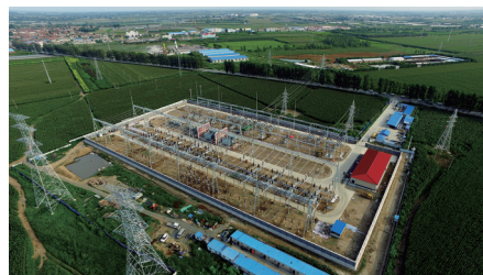
220千伏高花变电站
