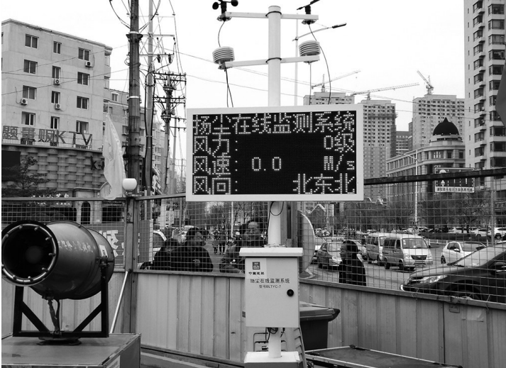
在沈辽路快速路施工现场,施工单位安装了可现场实时监控扬尘颗粒物的远程视频监控系统。
