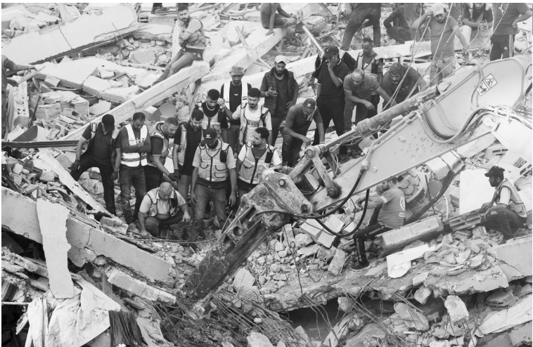
9月16日,救援人员在加沙城的建筑倒塌现场搜救。巴勒斯坦加沙地带加沙城一栋建筑倒塌,造成至少11人死亡、至少100人失踪。
