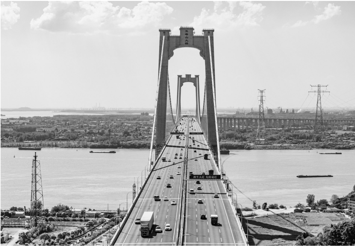
图为在江苏镇江拍摄的五峰山长江大桥上的车流(无人机照片)。
