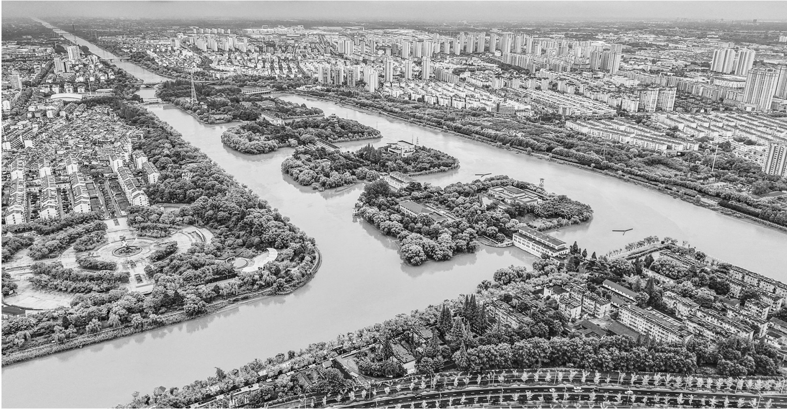
图为8月11日拍摄的位于江苏省扬州市江都区的南水北调东线源头江都水利枢纽（无人机照片）。
