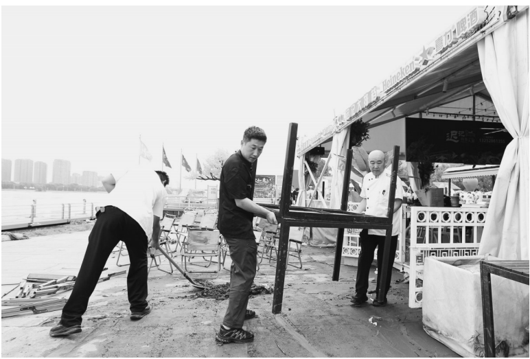
强降雨过后,沈阳浑河外滩市集进入修复阶段。7月17日,商户清理受潮物品,检修摊位电路与设备。浑南区环卫、消防、公安等部门工作人员集中开展清淤作业,对场地、商铺设施全面冲洗消杀。现场人员分工协作,加紧消除安全隐患,争取早日完成修缮工作。 图为商户清理受潮物品和淤泥。 本报记者 白 琳 摄
