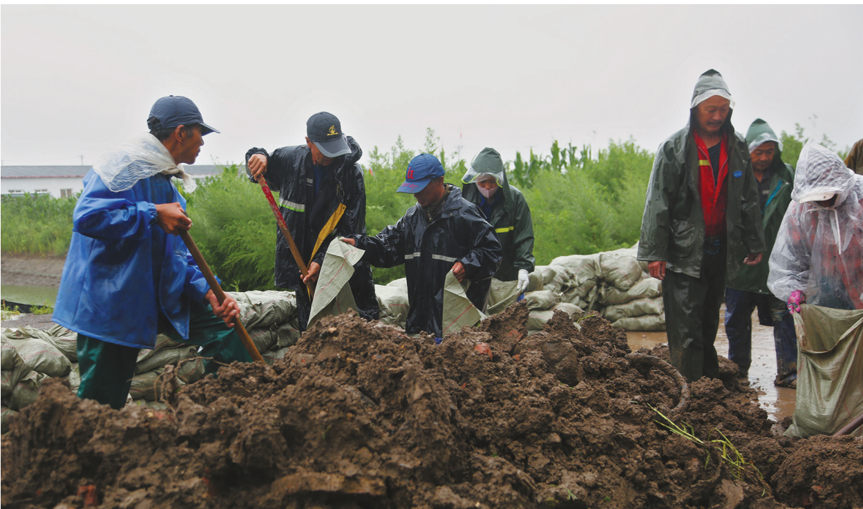
在盘锦市大洼区,施工人員加固辽河生态示范路子堤。
