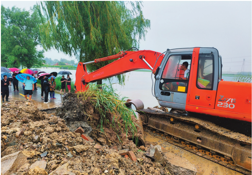
沈阳市沈北新区兴隆台街道紧急调派挖掘机打通淤堵。 本报记者 杨靖岫 摄
