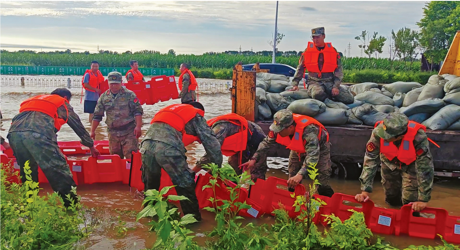
铁岭市银州区人武部集结基干民兵,紧急奔赴光荣街南段险情路段开展防汛作业。 于洪振 邹新江 摄
