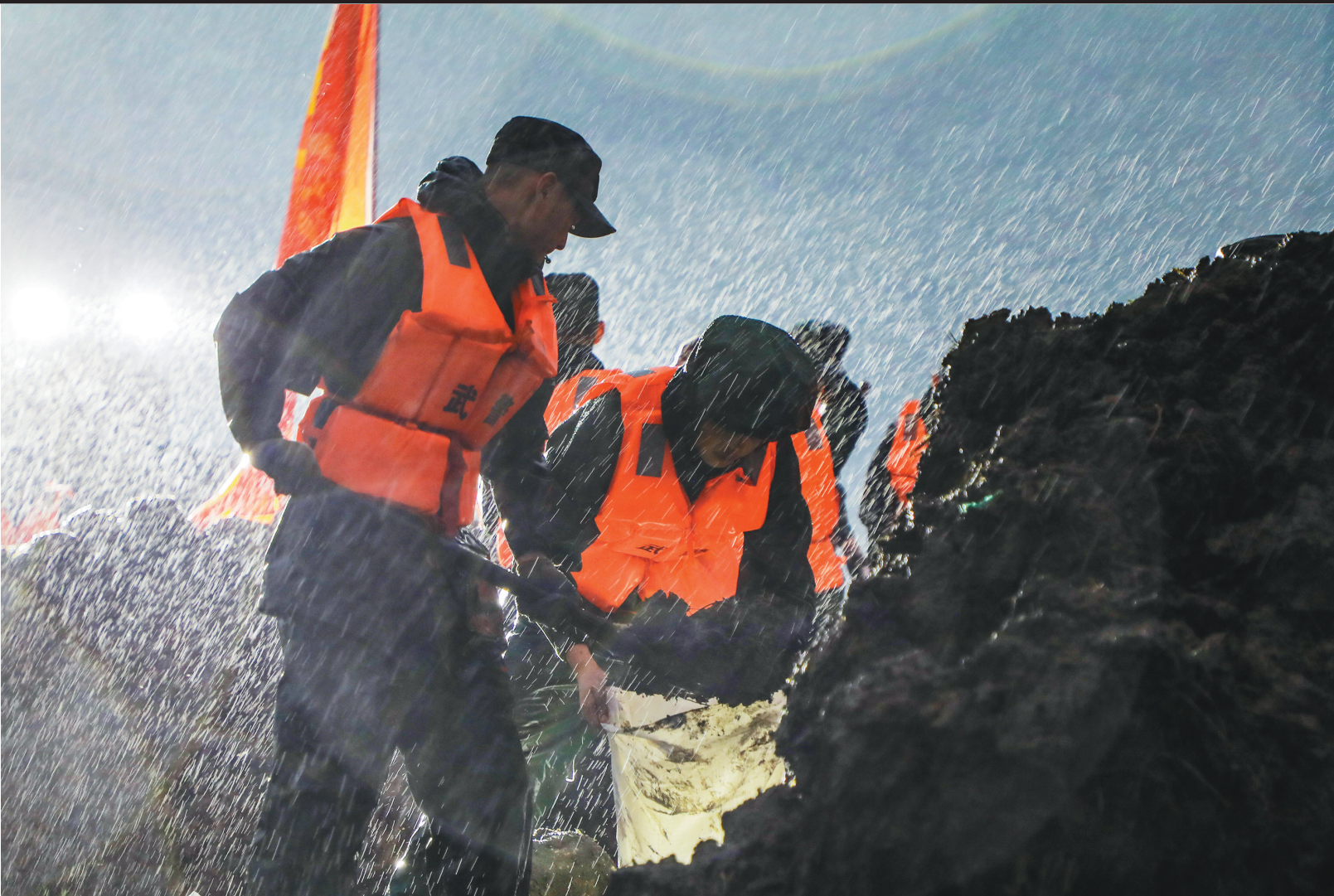
武警辽宁总队沈阳支队官兵紧急驰援蒲河新民段防汛一线,全力开展堤坝加固工作。 卫振伟 邹新江 摄
