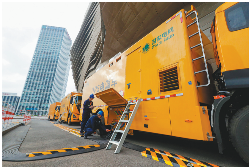
国网大连供电公司工作人员调试应急电源车，做好供电保障工作。
