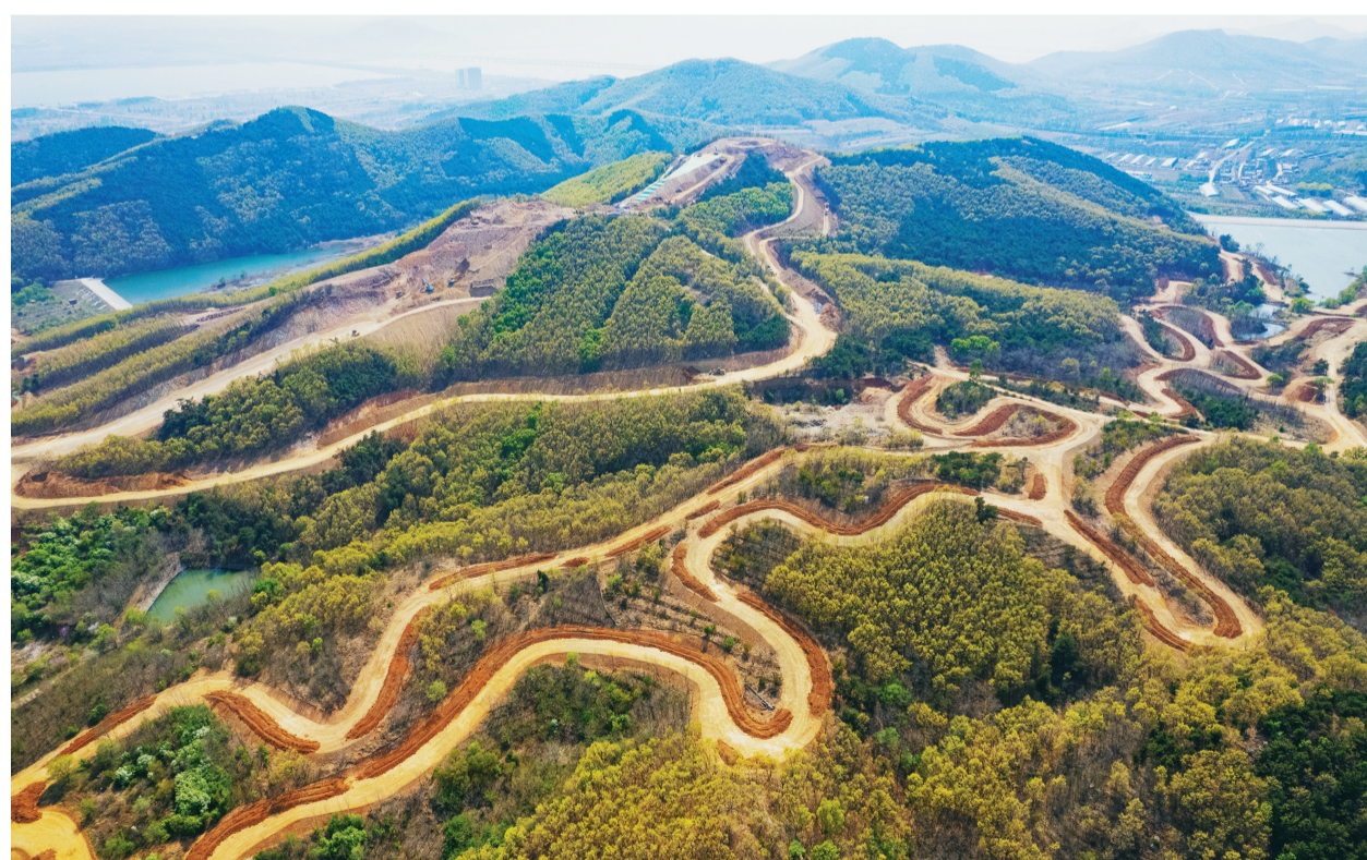
图为正在建设中的“十五冬”大连赛区越野滑雪场。
