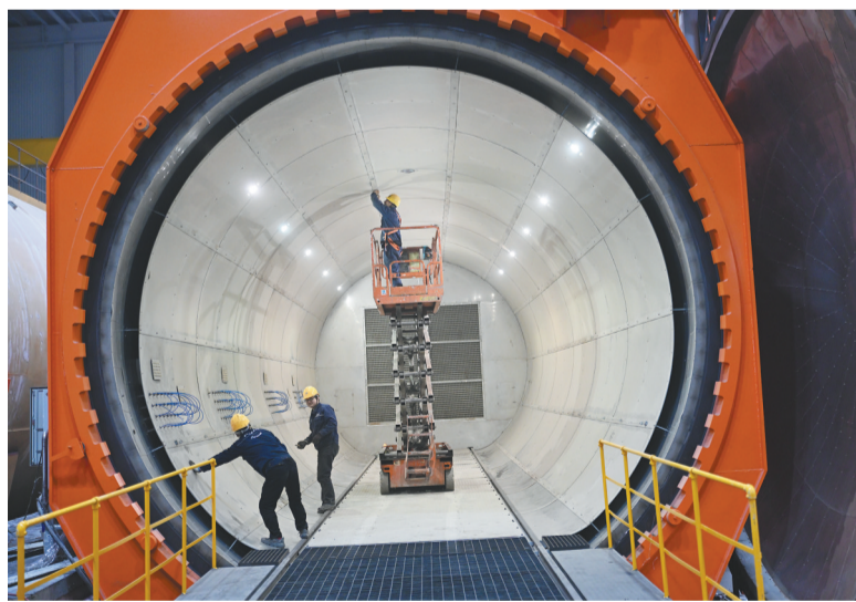
图为项目建设现场,技术人员正忙着安装调试。 本报记者 杨靖岫 摄
