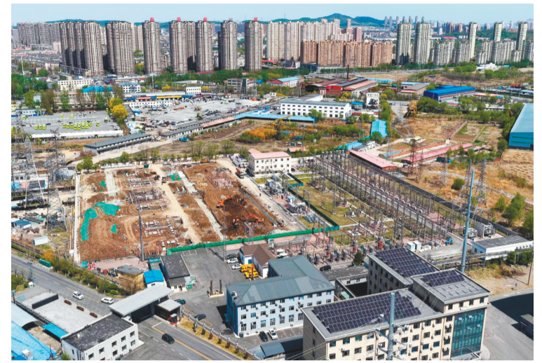
图为施工现场。
