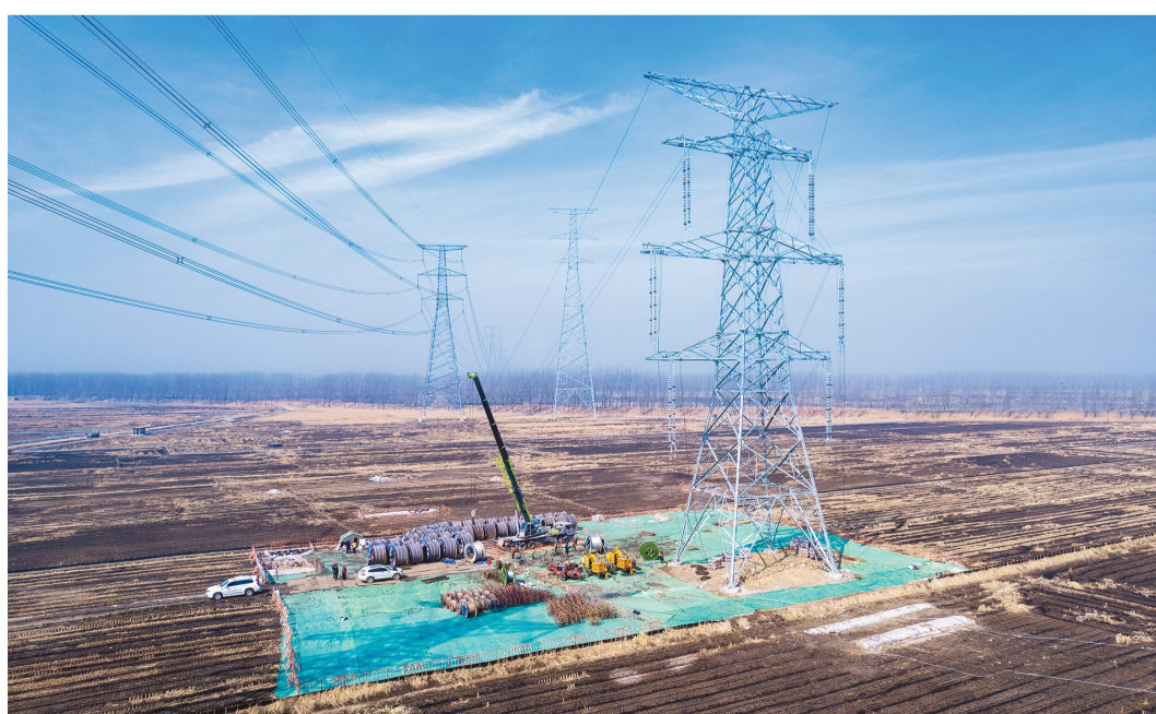
图为辽西—辽中500千伏断面加强工程施工现场。张砚耕 摄
