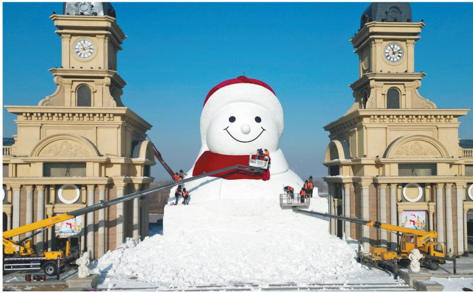
12月14日,正在建设中的哈尔滨群力音乐公园网红大雪人头部已完成,露出憨态可掬的笑容。今年回归的大雪人将在保留红帽子、红围脖、红色爱心纽扣“经典皮肤”的基础上,再次升级。设计身高19米、长14米、宽11米,比往年“长高”1米,总用雪量超过3000立方米,比往年增加1200立方米,达到历年之最。图为12月14日拍摄的建设中的哈尔滨市群力音乐公园网红大雪人(无人机照片)。
